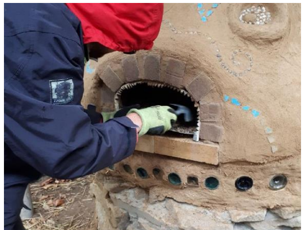
Sand wird nach einem Monat Trocknung rausgeholt
