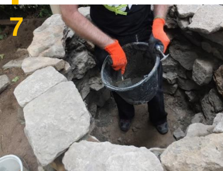
Natursteinmauer innen verfugen
