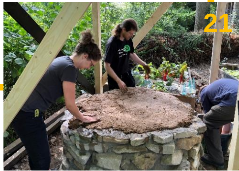
Erste Lehmschicht auftragen
