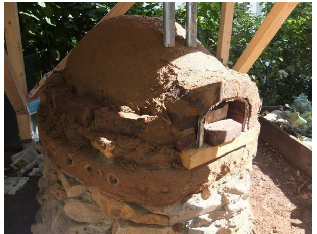
Unterste Lehmschicht mit den Schornsteinrohren
