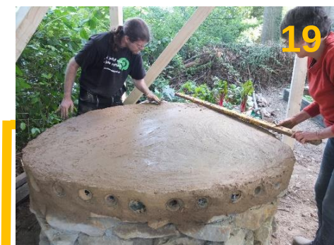
Flaschen mit Lehm bedecken und Isolierschicht begradigen
