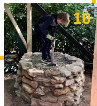
Fundament verdichten
