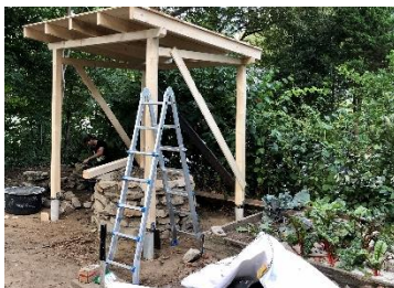
Bretter zur Dacheindeckung
