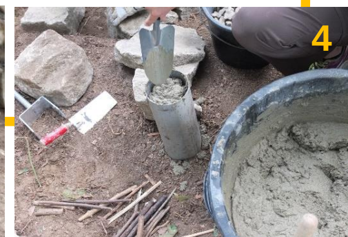
Fundamentschuhe mit Beton füllen
