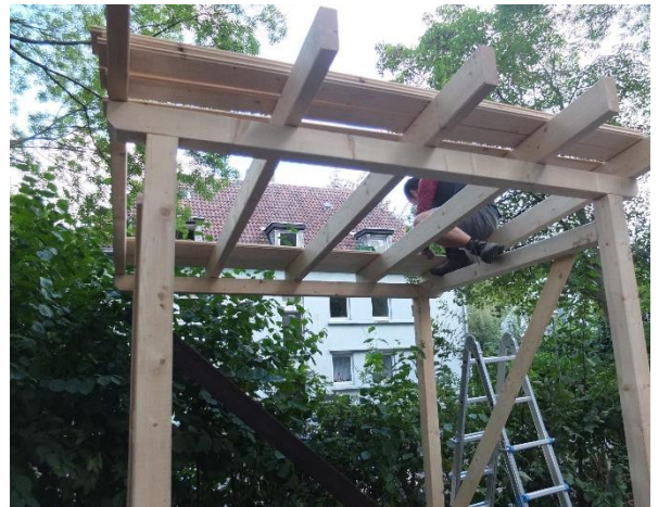
Bau der Dachkonstruktion
