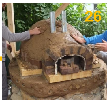
Zeitungsschicht über Sandkuppel mit Lehm bedecken
