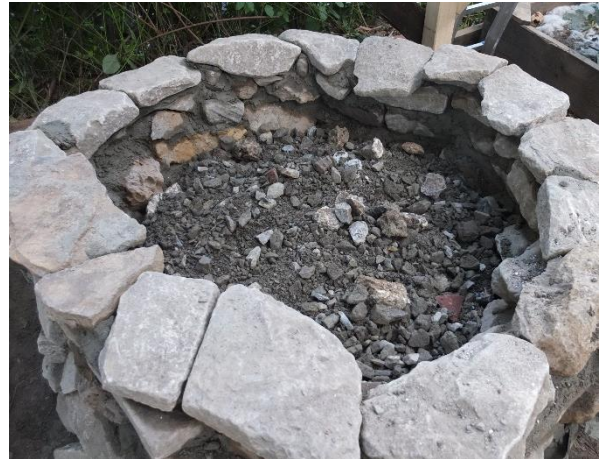
Gemauerter Fundamentring mit Schotterfüllung
