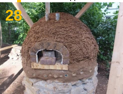
Lehm-Strohschicht auftragen
