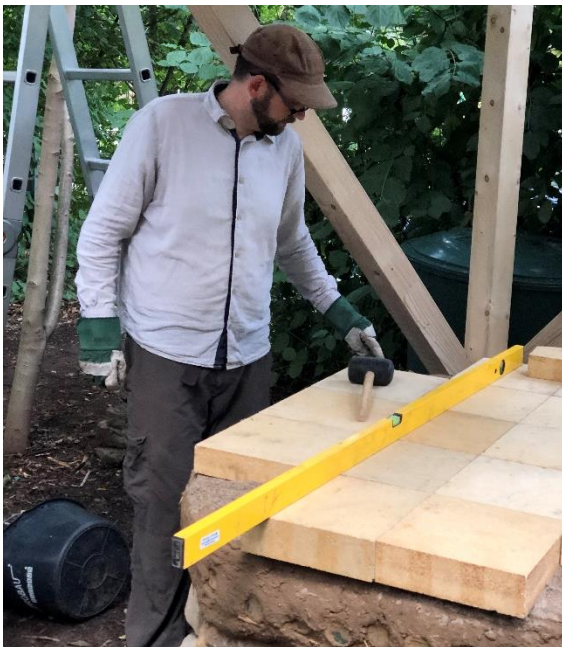
Backfläche aus Schamottsteinen in Waage bringen
