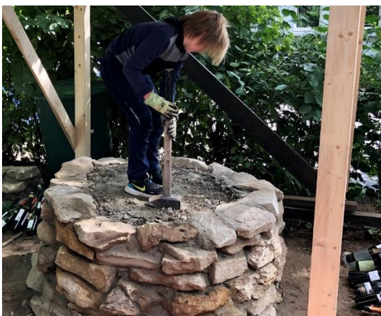
Schotter wird verdichtet
