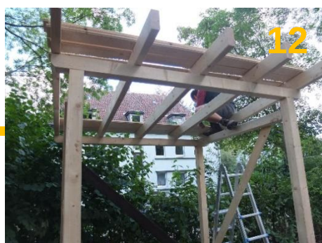
Dachbalken und -bretter befestigen
