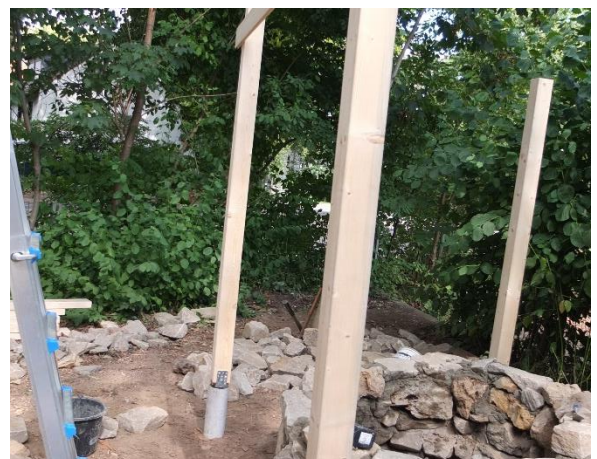
Pfahlfundamente und Dachpfosten
