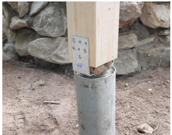
Fundamentschalung mit Pfostenanker
