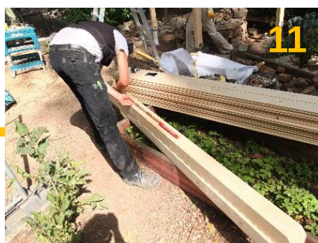
Dachkonstruktion zuschneiden
