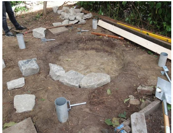
Loch für Ofenfundament mit den ersten Steinen
