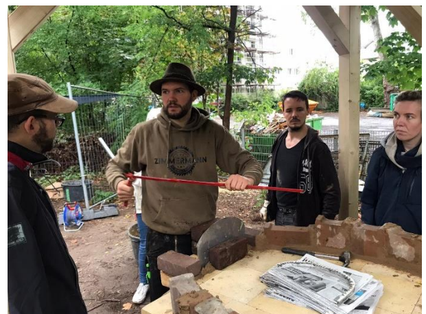
Schamottsteine auf Schamottplatten ausrichten
