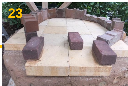
Schamottsteine in Lehm setzen/verfugen
