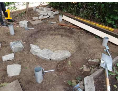
Fundamente und Loch platzieren
