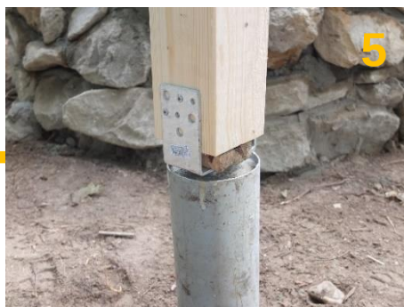
Fundamentschuhe setzen
