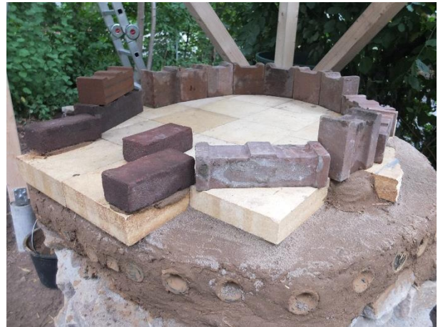
Ofenfundament mit Schamottplatten und Schamottsteinen
