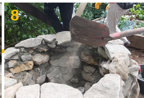
Ofenfundament mit Schutt verfüllen
