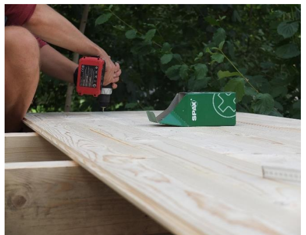
Dachbretter werden verschraubt
