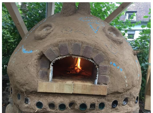
Erstes kleines Feuer zur Trocknung des Ofens
