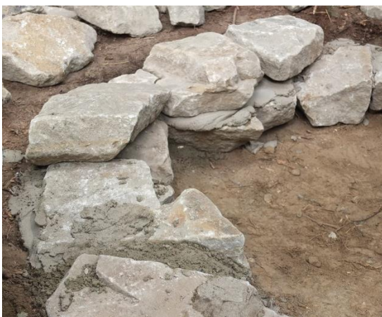
Ringfundament aus Bruchsteinen (Ofen)
